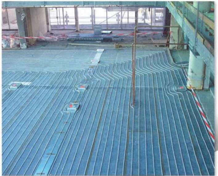
Neu verlegt mit flexiblem Rohr Für die neue Fußbodenheizung kam das flexible und langlebige Flächenheizungsrohr „KME/Q-tec“ zur Anwendung
